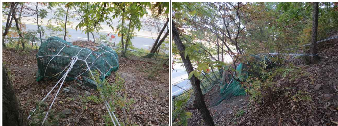
1 (10공구) 기타종사면21 (21.52K) 자연사면 암괴 포획 ⇨ 주의관찰
